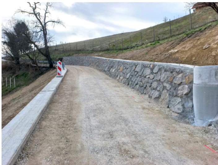
Urejeno in sanirano je tudi plazovito območje v Gradiščih pri Arnečičevih.
