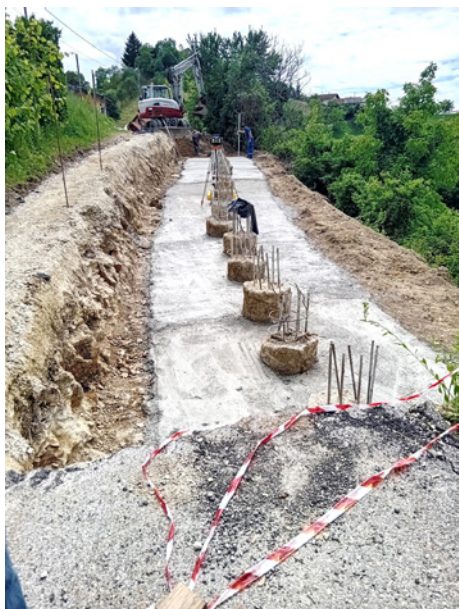
Poteka sanacija plazov v Gruškovcu.
