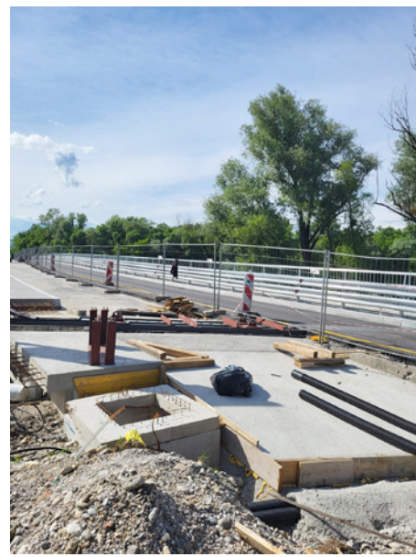
Rekonstrukcija mostu z dogradnjo kolesarskih poti v Dolanah pod Borlom poteka po načrtu.
