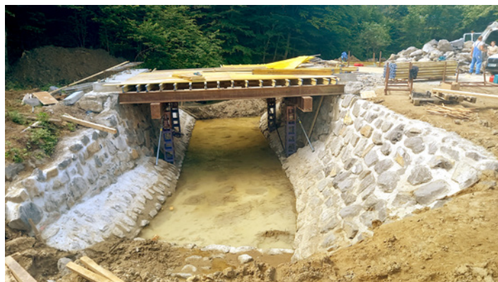
V Dolanah poteka rekonstrukcija poškodovanega mostu.
