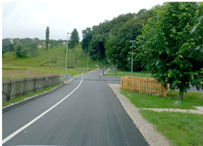
Zaključena je konstrukcija ceste z dvema mostovoma in dvema večjima propustoma in javno razsvetljavo na odseku Medribnik–Cirkulane. Foto: arhiv občine
