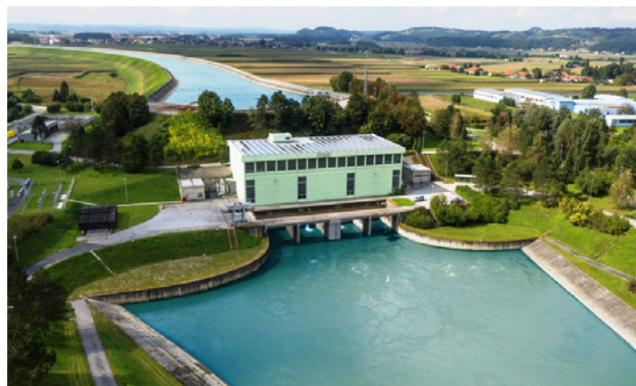
Hidroelektrarna Formin in dovodni kanal Foto: arhiv DEM
