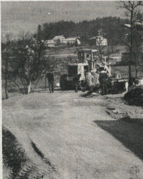
Zadnja dela pred asfaltiranjem ceste Studenec—Škocjan.
