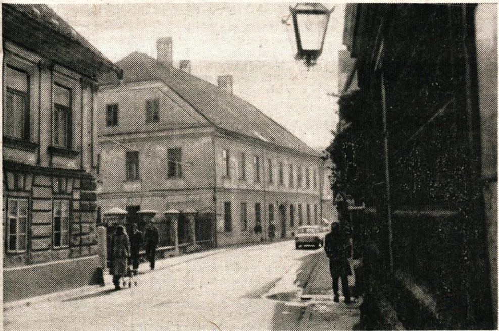
Pogled na objekt Kidričeva 35. Iz severa.
