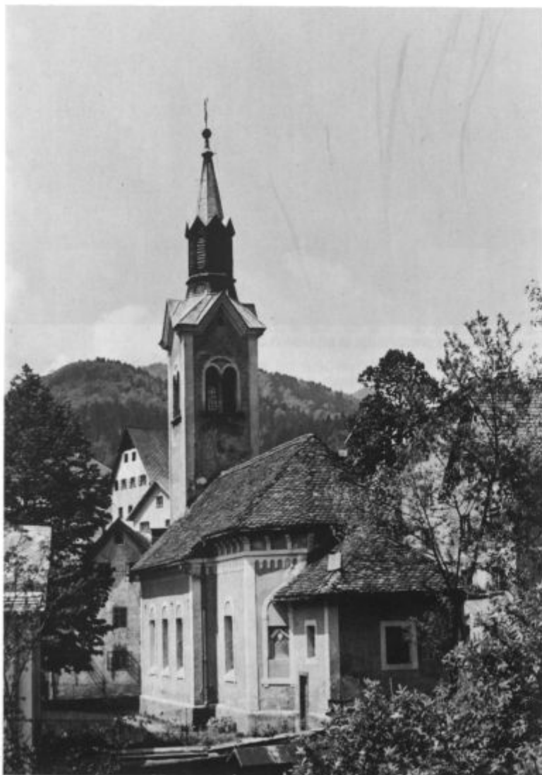
Cerkev sv. Trojice pred obnovitvijo. Foto: Jože Rupnik (sl. 5)
