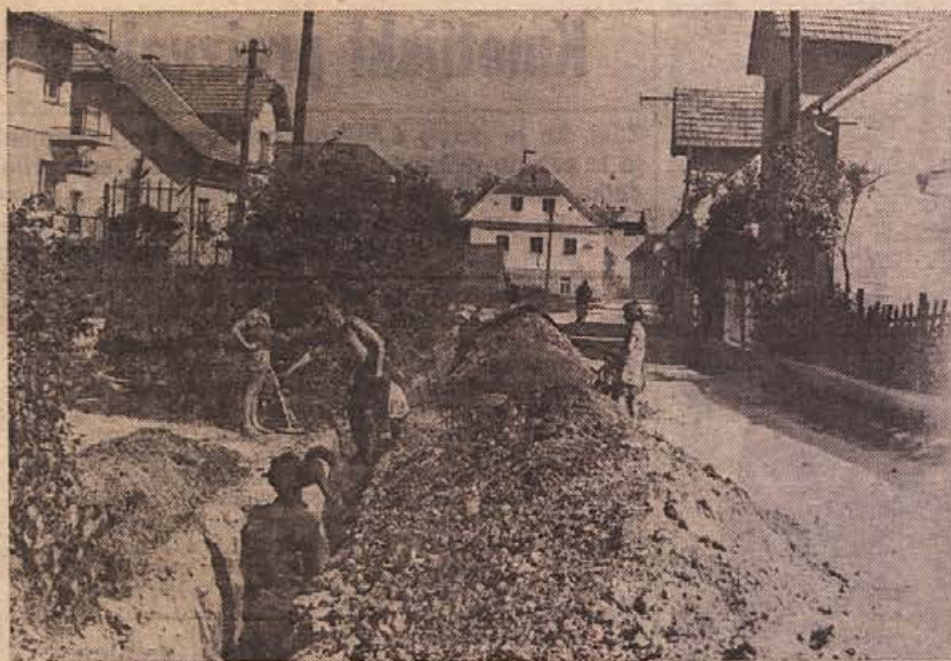
Gradnja vodovoda v Senterneju razmeroma hitro napreduje. Jarek za glavni vod je izkopen že do središča Senterneja. Z bagrom napravijo jarek, prebivalci ga poglobijo še z lopatami (Foto: Polde Miklič)
