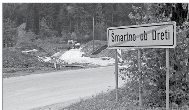
Območje Biča med izvedbo komunalne infrastrukture (Foto: Marija Lebar)
