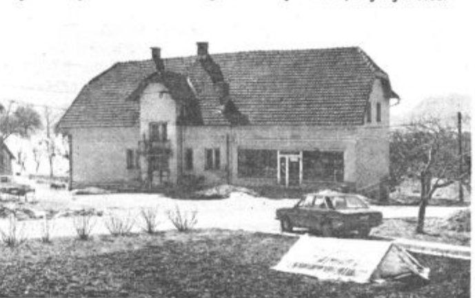
Objekt, v katerem je bila trgovina v Škalah, je že močno razpokan in prodaja v njem ni bila več varna. Fotografija je že malo zastarela, saj so razpoke danes še večje
