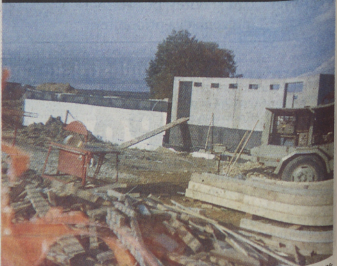
Čistilno napravo v Bogojini gradijo delavci SGP Pomurgrad. Denar zanjo je namenila občina Moravske Toplice, izdaten pa je tudi prispevek gospodinjstev, in sicer v povprečju 150.000 tolarjev. – Foto: F. Re.
