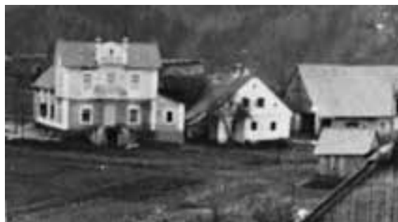
Društveni dom na Dobračevi, zgrajen v letih 1909–10, pogled z današnje Loške ceste (od Dekla) na severno fasado oziroma na zadnjo stran
