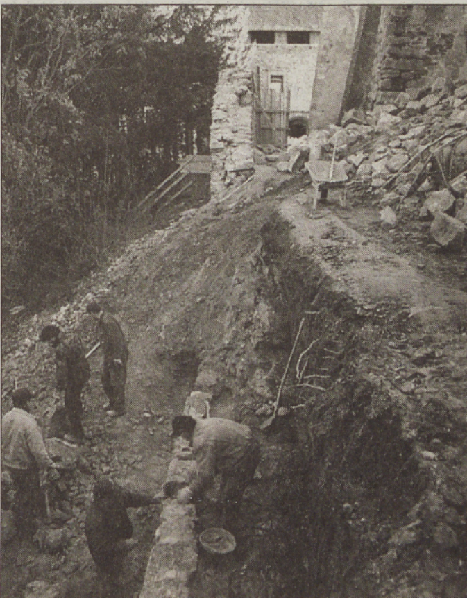
Pogled na obnovitvena dela na severnem delu grajskega obzidja na gradu v Negovi. - Foto: L. Kr.
