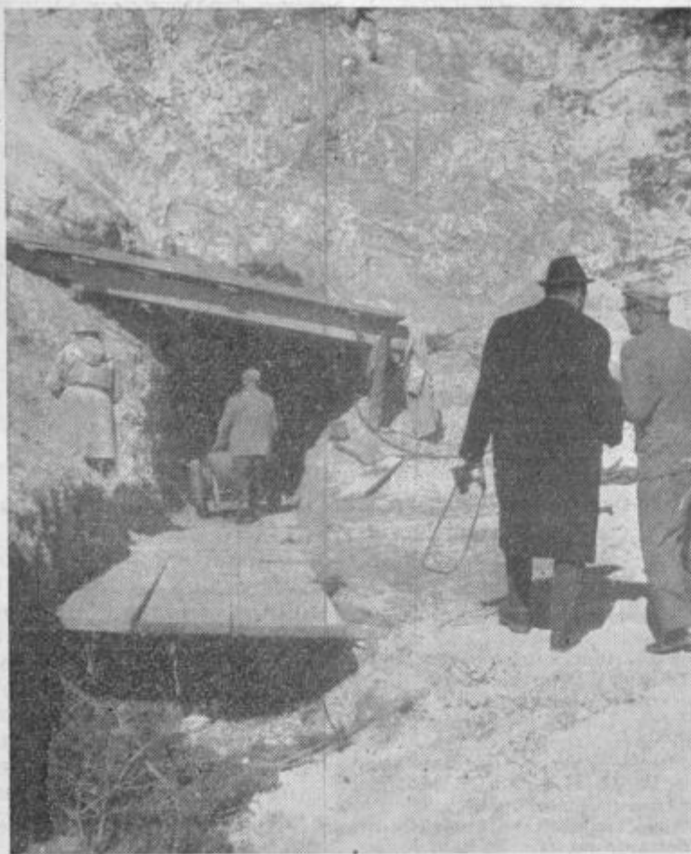
Skozi ta rov bodo speljali cevi novega vodovoda
