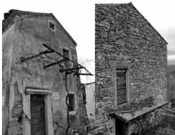
Slika 13, 14: Zapuščen stanovanjski objekt v centru naselja z ometano fasado, kamnitimi okvirji vrat in oken ter leseno oporo za vinsko trto. Objekt je samostojen, z manjšim vrtom ob strani. Zapuščen gospodarski objekt na vstopu v naselje z vidno kamnito fasado in manjšim številom odprtín. Objekt je samostojen in delno vkopan z ločenim vhodom v klet po spodnjem nivoju.
