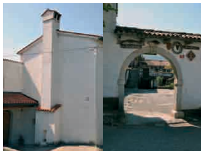
Slika 1: Kraška hiša, elementi arhitekture. Foto: Maja Brate.
