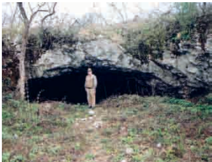
Slika 15: Za potrebe hranjenja ledu je služil tudi naravni spodmol, vdolbina pod previsom, katerega vhod so delno zaprli z zidom, s čimer so preprečili vdor toplega zunanjega zraka v notranjost, kjer je bil shranjen led Eden takih je Oštirjeva ledenica v pečini pri Baruški v Povžanah, katere vhod je obrnjen proti jugu, kar je bilo za hrambo ledu v njej zelo neugodno, saj se je začel ob dvigu temperatur hitro topiti. Foto E. Belingar, 2002.
