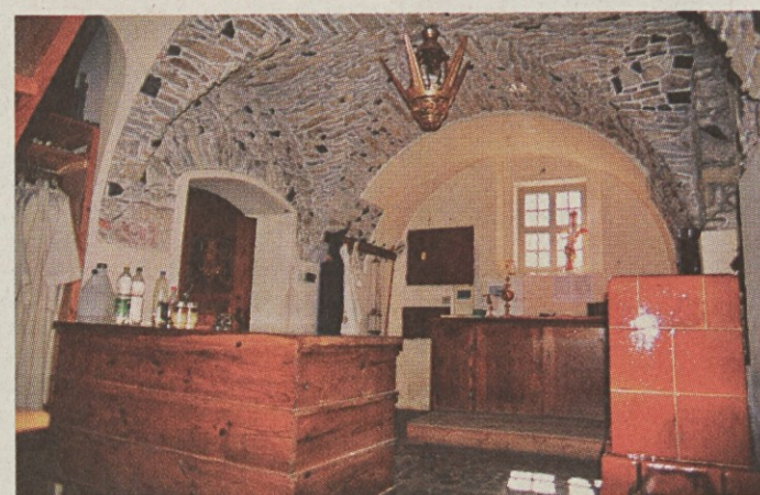
Zakristija, v kateri je Plečnik očistil omet s stropa tako, da je vidna kamnita konstrukcija.
