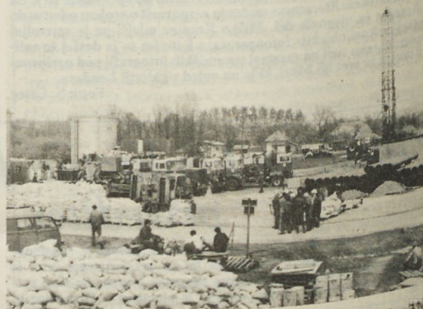
Raziskovanje petišovskega polja. Vrtnina Pg-6 je globoka 3200 metrov in daje dnevno pet do deset tisoč kubičnih metrov zemeljskega plina. Predvidevajo naj bi ta vrtnina po končanem raziskavah dajala do 30.000 kubičnih metrov plina dnevno.
