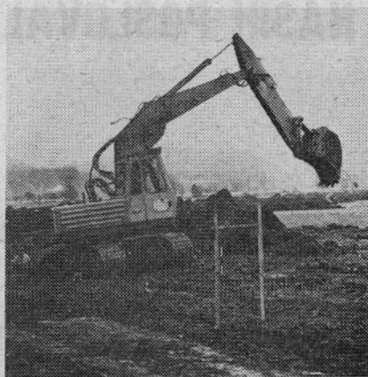
Gradbena sezona je v teku. Z modernimi stroji gre vse hitreje.
