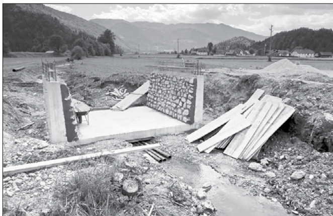
Namestitev novega in večjega prepusta bo preprečila nadaljnjo škodo.
