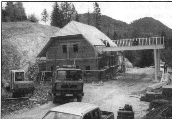
Gradnja skupnega objekta na meji pospešeno napreduje (foto: Ciril Sem)
