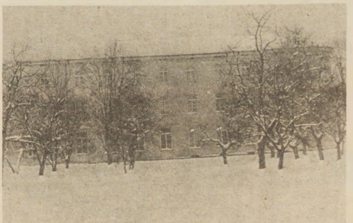
Prostori sedanjega doma VIZ Veržej, ki so v nekdanjem salezijanskem zavodu, že zdavnaj ne ustrezajo vzgojno-izobraževalnemu procesu, zato bi bilo nujno začeti z gradnjo novega doma.
