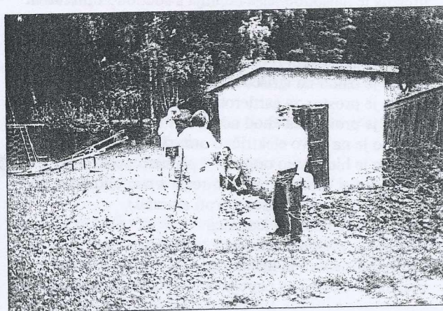
Javni delavci pri obnovi vodovoda pri osnovni šoli.
