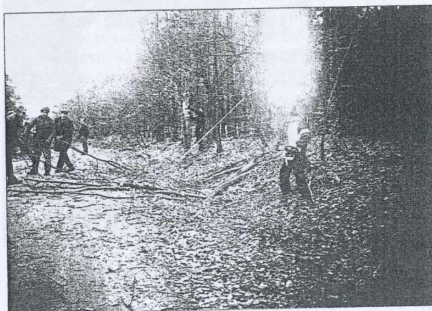
Javni delavci pri poseku na cestah.
