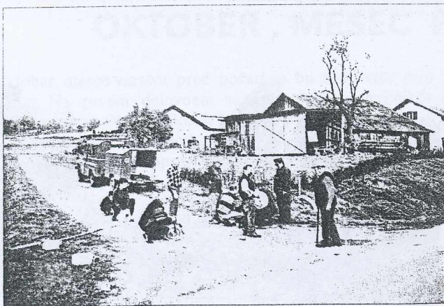
Slika prikazuje, da so vajo člani PGD Šulinci končali in pri tem uporabili 10 B cevi in 4 C cevi. Vaje se je udeležilo 8 gasilcev.
