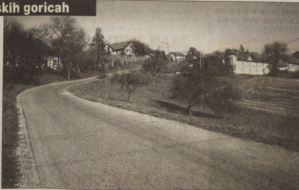
Precej gospodinjstev v Oseku še nima vodovoda, vendar ga bodo kmalu dobili prav vsi. Ker so hiše med seboj precej oddaljene, je namreč potrebno napeljati na kilometre vodovodnih cevi. Foto: F. Š.
