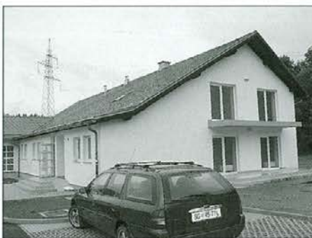
Dela na objektu šmiklavške šole so v zaključni fazi.
