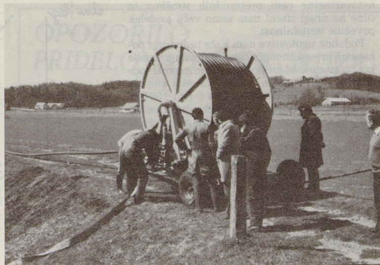
Leta 1984 je hmeljišče prvič poizkusno namakal pasovni namakalnik domače izdelave (poizkus v Lenartu).
