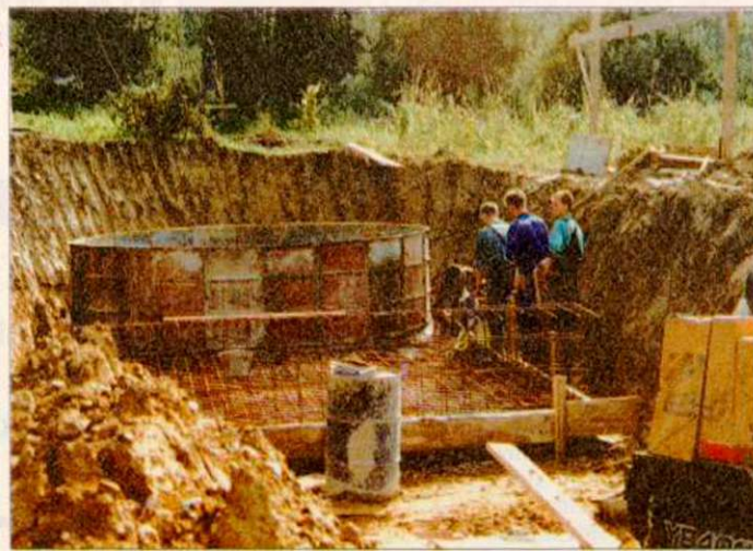
Ko bo zgrajen vodohran v Vitomarcih, bodo vodovodno omrežje priključili na mestni vodovod
