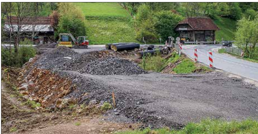
Prva faza gradnje novega krožišča je izdelava obvozne ceste v smeri Mozirje–Gorenje.
