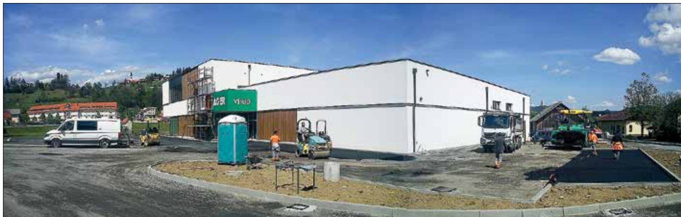
Gradbena dela na Jagrovem nakupovalnem centru so v zaključni fazi, odprtje je predvideno v mesecu juniju. (Foto: Nastasja Kotnik)
