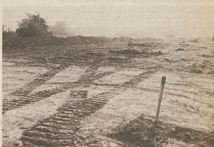
V bližini mejnega prehoda pri Vrtojbi so v torek začeli z deli na trasi avtoceste. Doslej so razpoložljiva sredstva za odsek do Šempetra in za obvoznico mimo tega kraja proti Novi Gorici. Na sliki (foto Pavšič) prva pripravljalna dela na trasi
