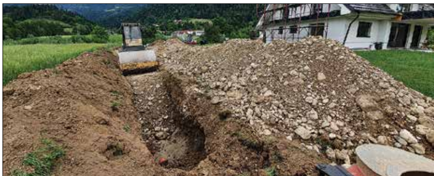
Zemeljska dela izvaja podjetje Gaber iz Okonine, polaganje kanalizacije in nadzor pa vrši JP Komunala Mozirje. (Fotodokumentacija Občine Ljubno)
