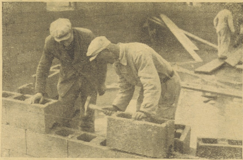
TAKOLE ZIDAJO BREZ MALTE V GERBIČEVI ULICI V LJUBLJANI LUKNJE ZALIJEJO Z BETONOM
