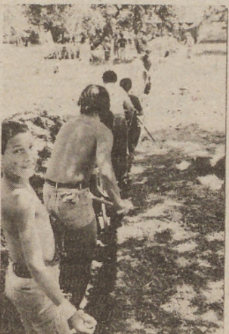
80 brigadirjev zvezne MDA Sloven- ske gorice 84 je v Ihovi izkopal ja- rek, položilo vanj cevi in ga zagrni- lo v slabih treh tednih.
