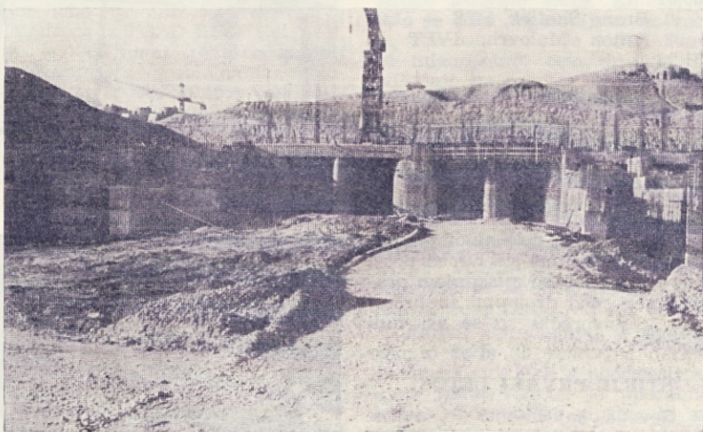
Pogled na strojnico dograjeno do montažnega platoja v HE HEMREN DAM (Foto: A. Razpotnik)
