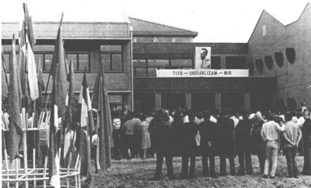
Z gradnjo prve šole s prostorskimi elementi so delavci Vegrada ponovno dokazali vsestransko uporabo teh elementov in številne prednosti industrijske gradnje
