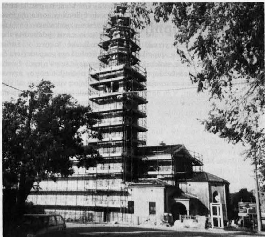
Obnovitvena dela pri župnijski cerkvi v Sovodnjah
