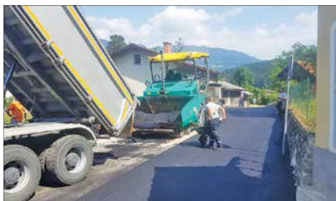
Hkrati z ureditvijo ceste Nazarje-Dobrovlje v dolžini okoli 100 metrov so sanirali tamkajšnji lokalni vodovod.
