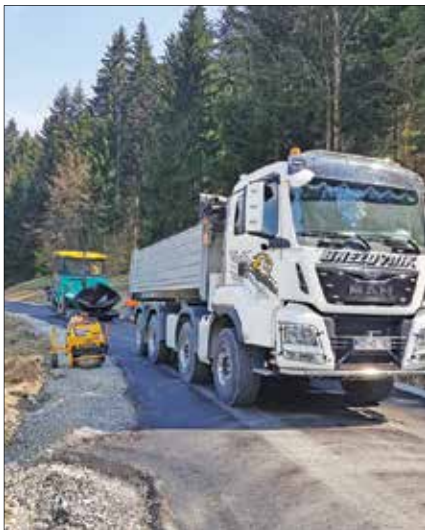
Po ureditvi plazu je bila rekonstrukcije in novega asfalta deležna tudi cesta v dolžini slabega kilometra.
