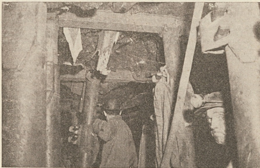
Jekleno podporje STT na širokem čelu Zgornjega VII. polja na rudniku Trbovlje Foto: inž. Tone Bregant
