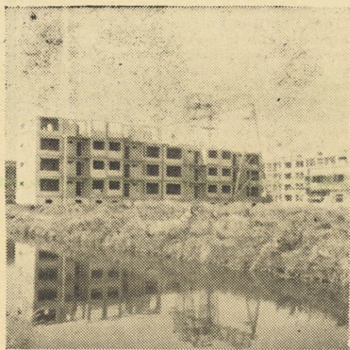
Sistem »Rottinghuit« — montaža
