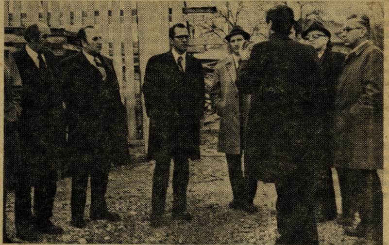
Andrej Marinc na gradbišču pod Golovcem
