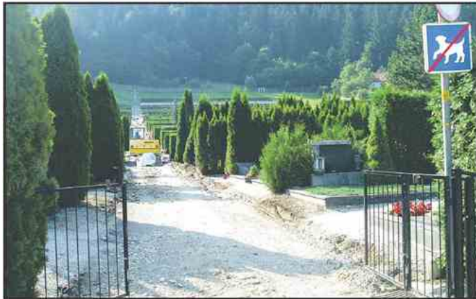
Ureajo še en del kanalizacije.
