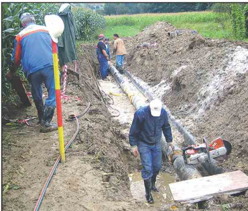
Neugodne vremenske razmere so precej otežile pogoje, v katerih je 62 delavcev opravljalo večja remonta dela na sistemu daljinskega ogrevanja Šaleške doline.
