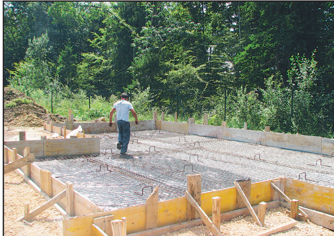
Prejšnji teden so zabrnili gradbeni stroji, ta teden so postavili temeljno ploščo in začeli postavljati lesen večnamenski prostor.
