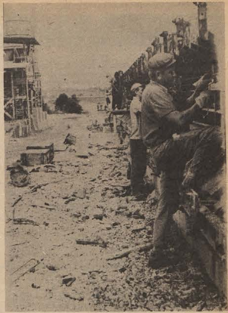
Priprava nosilcev za novi savski most v Brežicah. Vsak od njih tehta po 45 ton. Do 20. avgusta bodo dokončali vseh 37. To je zelo zahtevno delo. Gradis iz Maribora nekoliko zaostaja za planom zaradi pomanjkanja cementa in železa. (Foto: Jožica Teppey)
