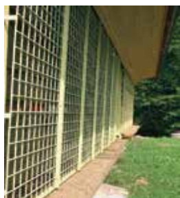
Mehansko varovanje z železno rešetko
