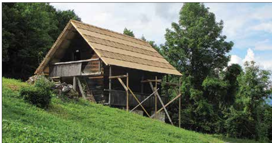
Tominškova kašča ima novo streho iz cepljenih škodel. (Foto: Marijan Denša)
