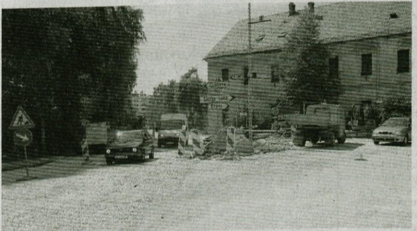
Delavci Cestnega podjetja Ljubljana hitijo z rekonstrukcijo križišča Ljubljanske in Kranjske ceste. Po novem bo uvoz na Ljubljansko cesto pravokoten.
