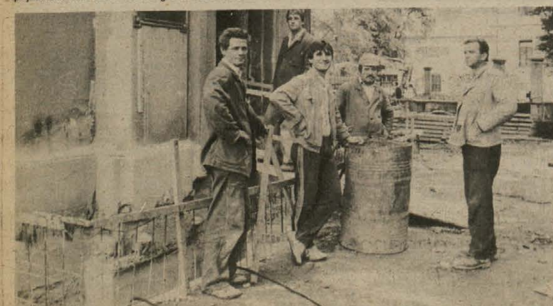
Skupina delavcev, ki dela pri zanimivem projektu »dviganja« ogroženih kulturnih spomenikov.
