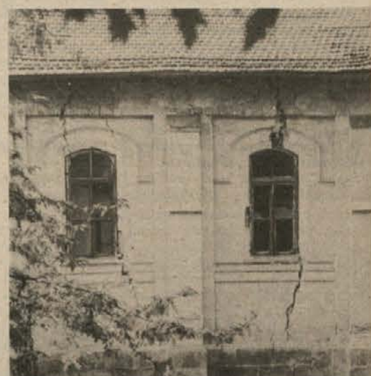
Razpoke na strehah stavb, kot je še neporušen del nekdanje gimnazije (na sliki), so znamenje ugrezavanja tal. Te tuzlanske »gube« pomenijo prezgodnjo starost in gotovo smrt.
