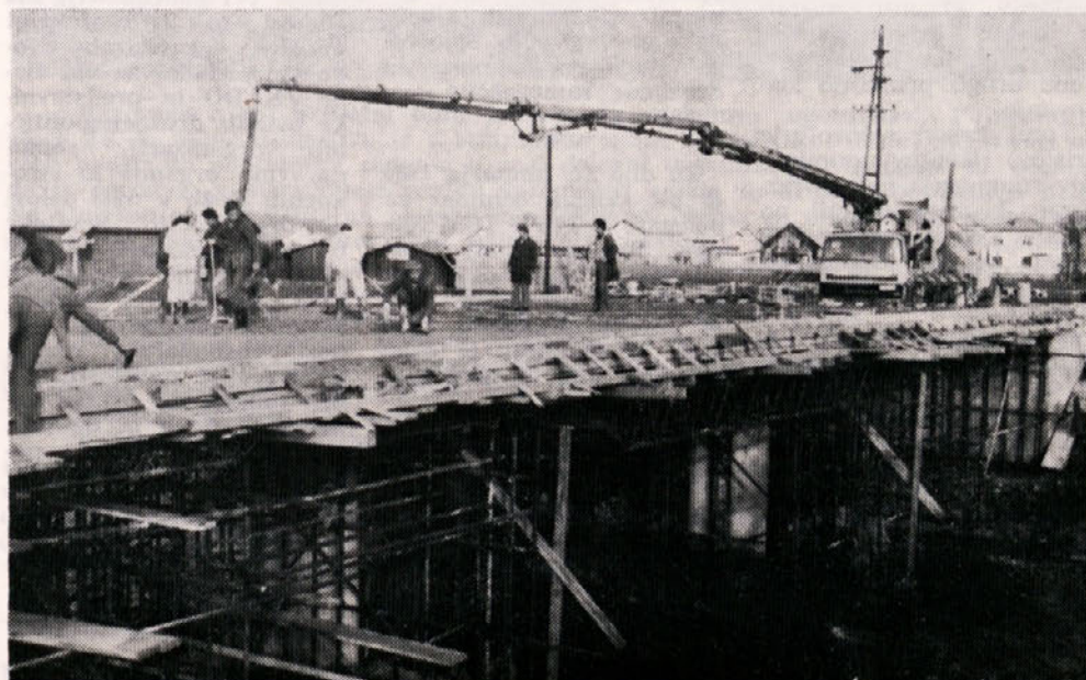
Dan betoniranja plošče na mostu čez Ložnico v Celju.
