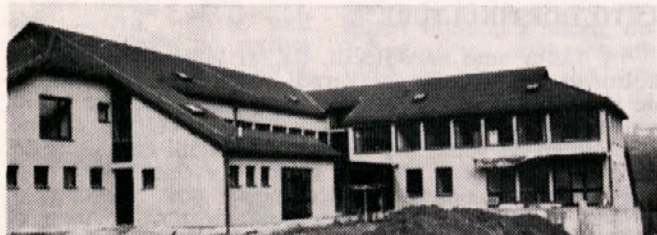
Zaključujejo se dela na Zdravstvenem domu v Štoreh
