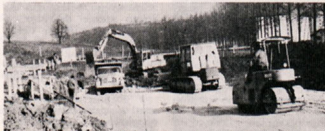
Mehaniziran pristop k izkopu gradbene jame
