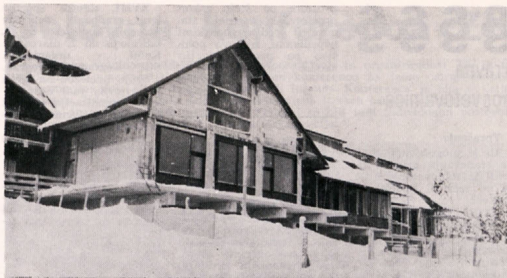
Gradbišče Hotela na Rogli (na višini 1517 m) zasuto s snegom.
