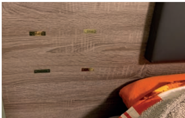
▲ Na dotik občutljiva tipala za upravljanje luči, vgrajena ob postelji.
