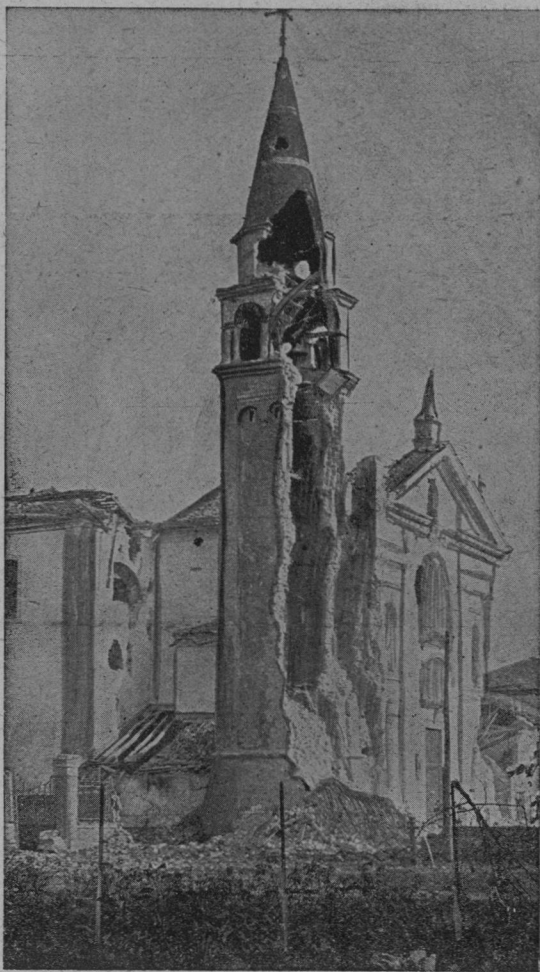
Sledovi vojne: Ponte di Piave v Benečiji ima čudno razparan zvonik, žrtev topov.
