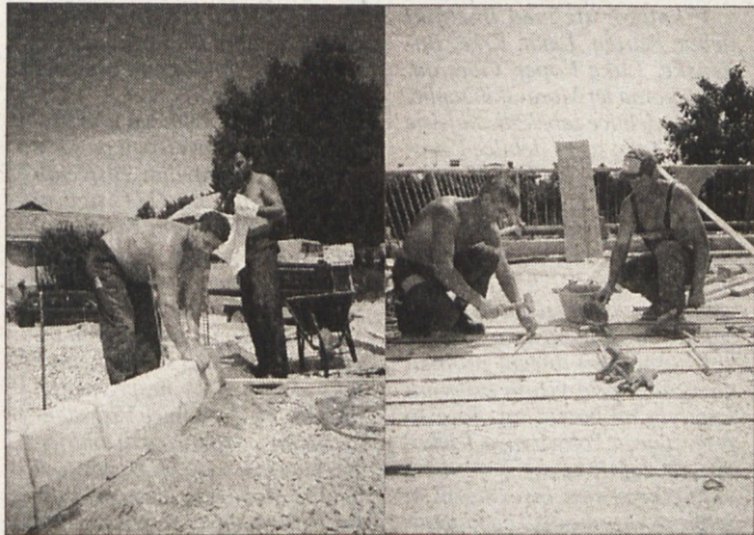
KRIŽIŠČE IN MOST - Gradbena dela na mostu čez Savo v Krškem in bližnjem krožnem križišču so v polnem teku. Obnova mostu in novogradnja križišča sta kljub poletnim dopustom vnesla kar nekaj zmede v promet - ureditev na levi strani Save, vendar je bil zanj zadnji čas. Pa ne le zato, ker so ju napovedovale kot svoj veliki uspeh že prejšnje občinske garniture, ampak predvsem zato, ker vse številnejši avtomobili niso mogli več varno in brez zastojev čez Savo in v zelene smeri. Kdo bo v preklenski pripeki prej opravil svoje delo, ali graditelji križišča (na fotografiji levo) ali obnovitelji mostu (desno), se ne ve, znane pa so napovedi, naj bi po obeh cestnih objektih stekel promet še pred običajno jesensko gnečo. (Foto: L. M.)
