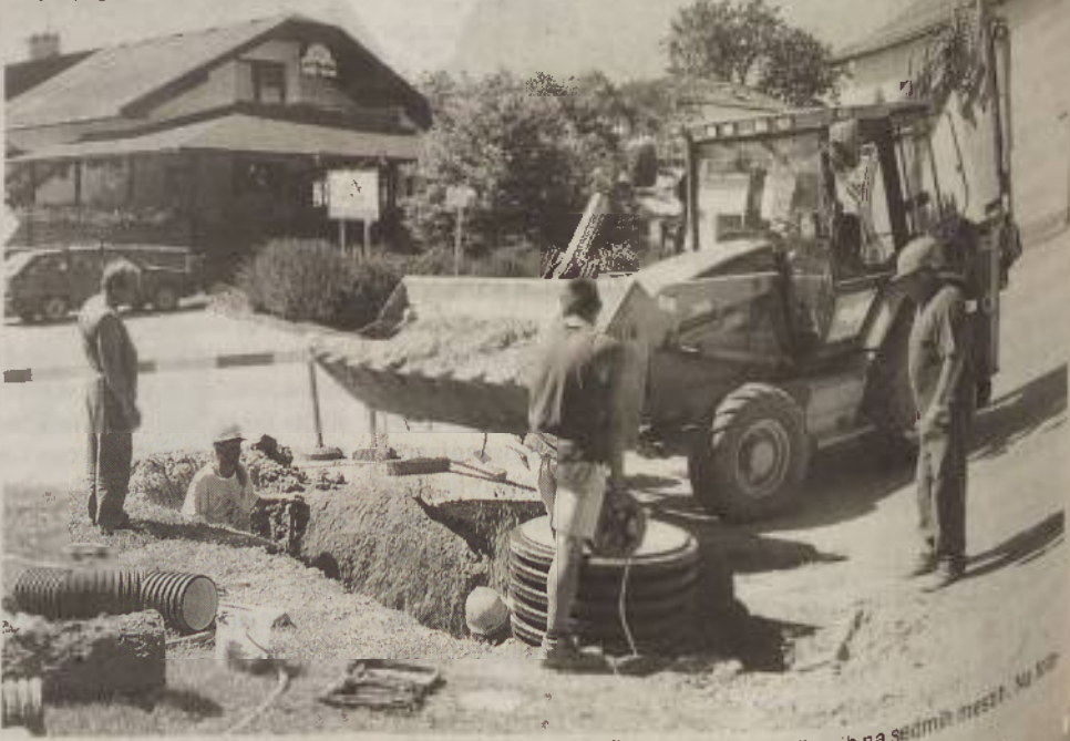
Trenutno potekajo dela pri izgradnji kanalizacijskega omrežja v Šalovcih in Domanjševcih na sedmih mestih. Na koncu grafiji je gradbišče pri občini.
