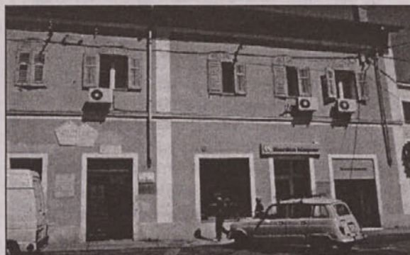
Tako pa je za zunanji videz stavbe na Kristanovem trgu in za sejno sobo občinskega sveta poskrbela občinska oblast.
