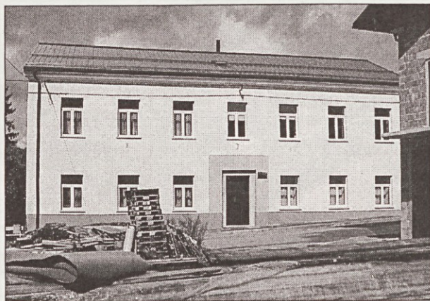
Nova fasada Glasbene šole Ilirska Bistrica
