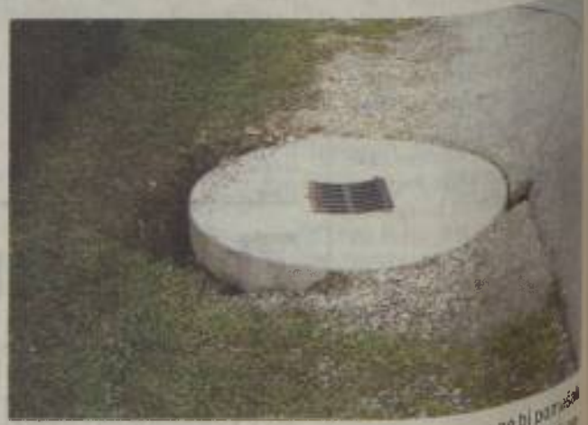
Kadar v Lipovcih malo bolj dežuje, je ta jašek premalo, da se ne bi porušil. »Prijateljci«, ki ne samo da zalijeta kletne prostore, ampak razdražita tudi nosne sluznice in okrasita ulico s fekalijami.
